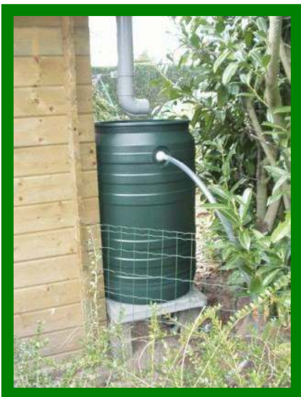
Een voorbeeld van afkoppeling van de regenpijp via een regenton. Door de overloop wordt regenwater afgevoerd naar de lager gelegen wadi in de tuin. voorbeeld www.voertonnen.nl
